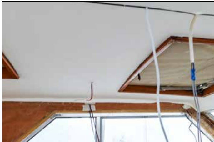
10. Det här är den svåraste biten att få till: två luckor, mittenlinjen, en sökarlampa och ett välvt ytterskott att förhålla sig till. Två personer krävs.
