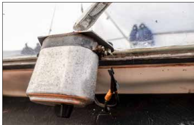
8. Se till att du skruvar bort alla kablar, fönsterramar och lister innan arbetet påbörjas.
