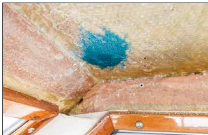
2. Täta alla hål där det kan läcka in vatten, så att inte ditt nya innertak saboteras vid första regn.
