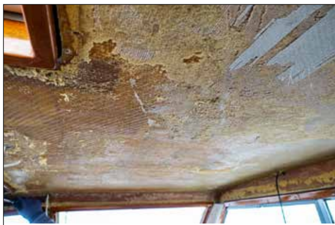
3. En stålborste är ett bra redskap för att få bort det gamla materialet. Men det bitar som sitter hårt fast kan lika gärna lämnas kvar.
