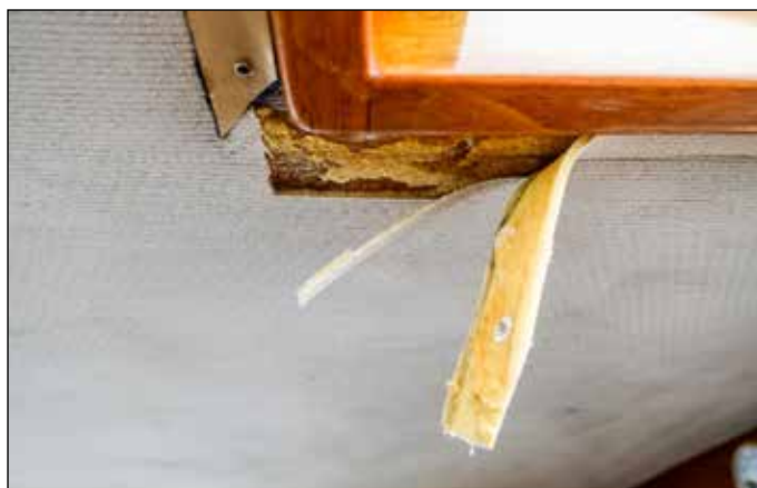
1. Så här såg Clara-Idas innertak ut före renoveringen.
