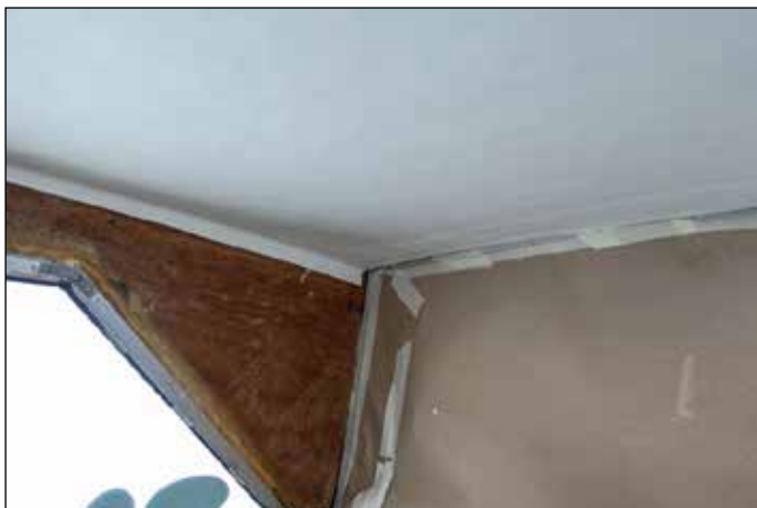
5. Täck de delar av båten där du inte vill ha lim.
